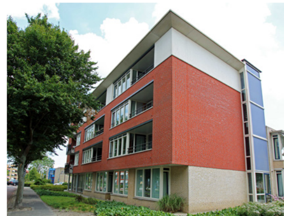
Het appartement, rechtsboven in het complex
